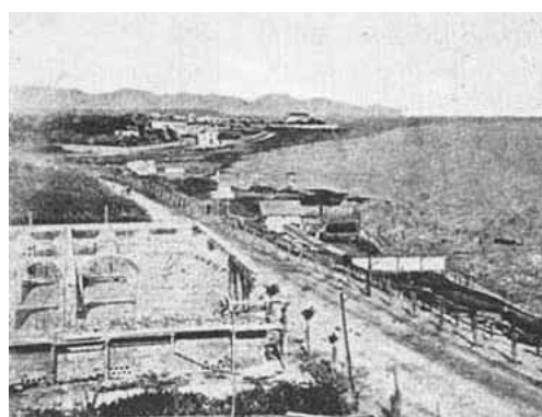
Il Municipio di Nettuno in costruzione.
