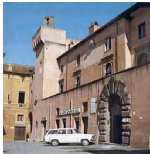
Palazzo Orsini. Prospetto su Piazza Marconi.
