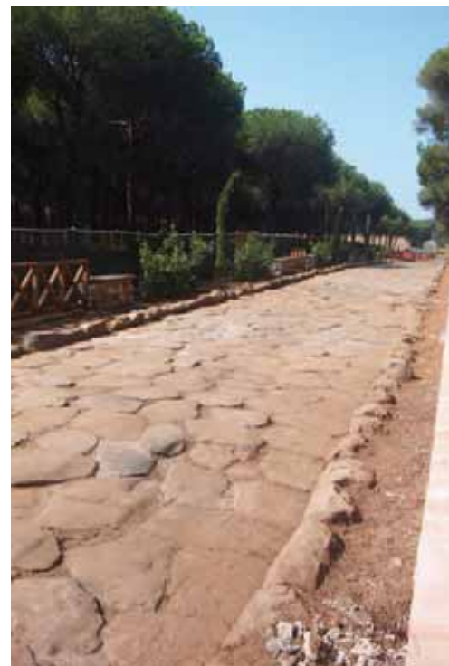
Tratto della via Antium-Lanuvium; durante i lavori di scavo.
