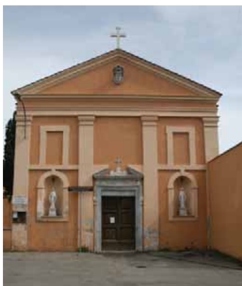
Chiesa di Santa Maria del Quarto.
