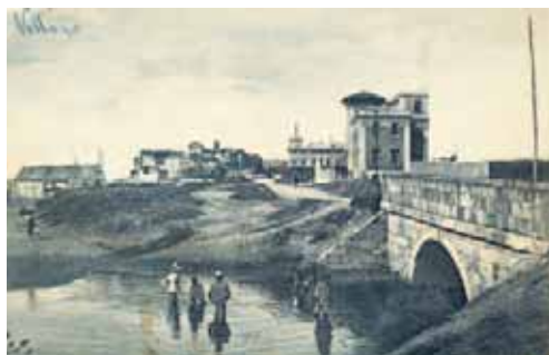
Nettuno: Ponte sul fiumetto Loricina.
