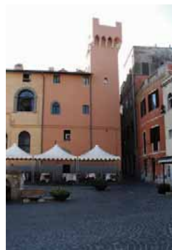
Palazzo Orsini. Prospetto su Piazza Colonna.
