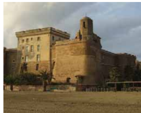
Forte Sangallo prospetto del lato mare.
