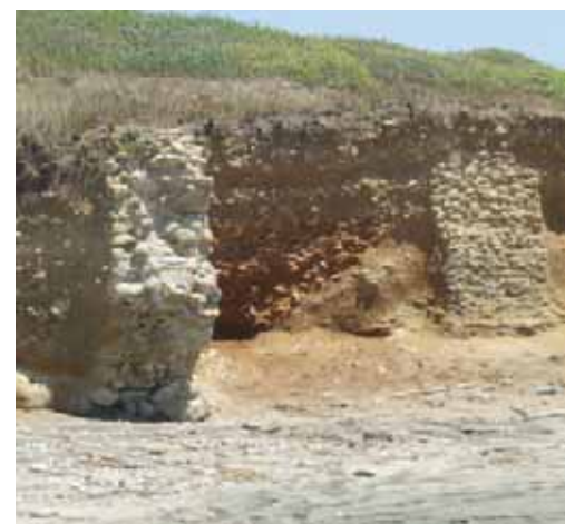
Villa delle Grottacce; la zona industriale.
