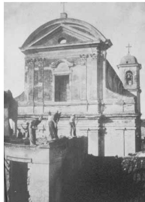
Demolizione delle case antistanti la chiesa di San Giovanni.
