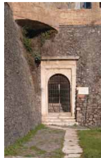
Ingresso al Cavone che dalla base delle mura permetteva una rapida salita in Via del Forno a Soccio.
