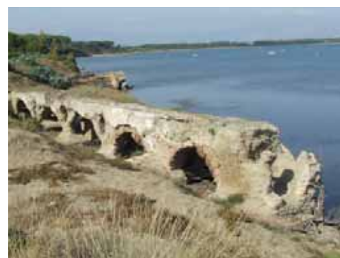
Astura; due immagini del ponte romano.
